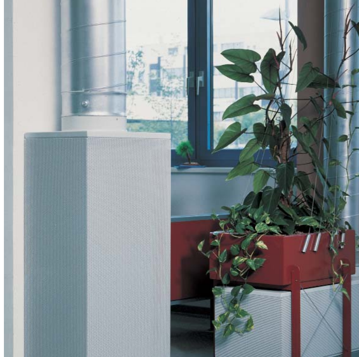
Rectangular displacement outlet, type Q-R, in the canteen of the publishing house 'Mitteldeutsches Druck- und Verlagshaus' at Halle / D
